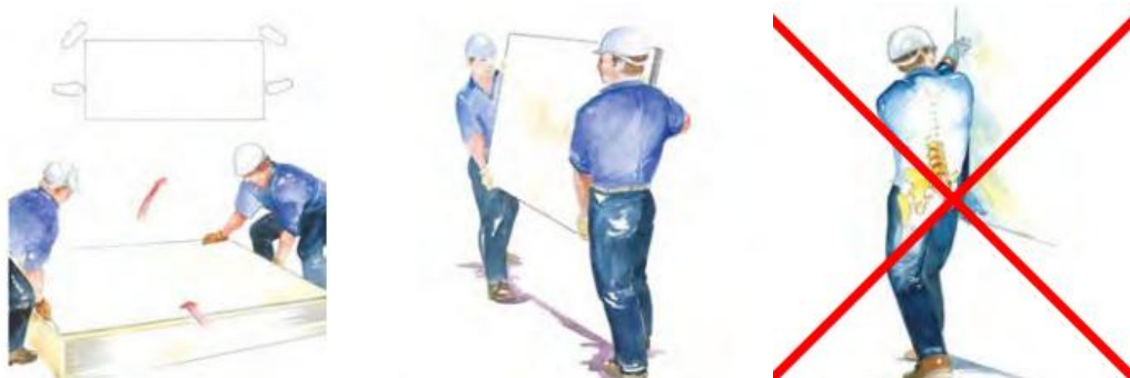
Rys. 2.5. Przenoszenie płyt kartonowo-gipsowych: dwie osoby.
