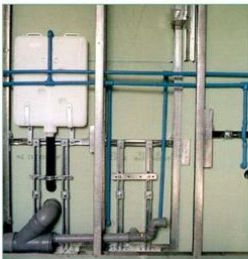
Rys. 3.14. Przykład z montażu suchej zabudowy. Źródło: training manual - I sistemi a secco a base gesso - Assogesso
