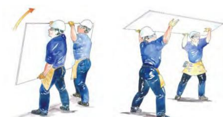
Rys. 2.7. Podnoszenie płyt kartonowo-gipsowych w miejsce instalacji (w tym sufity) - współpraca dwóch osób.
