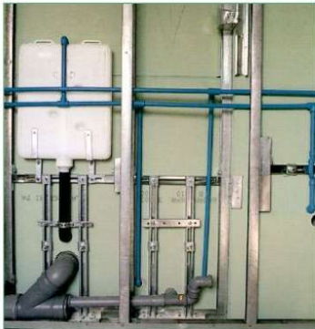
Figure 3.14. Gipskartonio pertvaros įrengimo pavyzdžiai. Šaltinis: Mokymo vadovas - I sistemi a secco a base gesso - Assogesso
