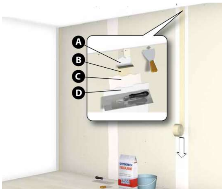
Pav. 3.61. Siūlių glaistymas. Šaltinis: “Manuale Tecnico: Soluzioni per interni” – GYPSOTECH - www.fassabortolo.it
