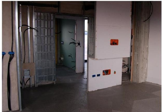
Fig. 3.13 – Esempi di installazione di sistemi a secco Fonte: Corso formazione - I sistemi a secco a base gesso - Assogesso
