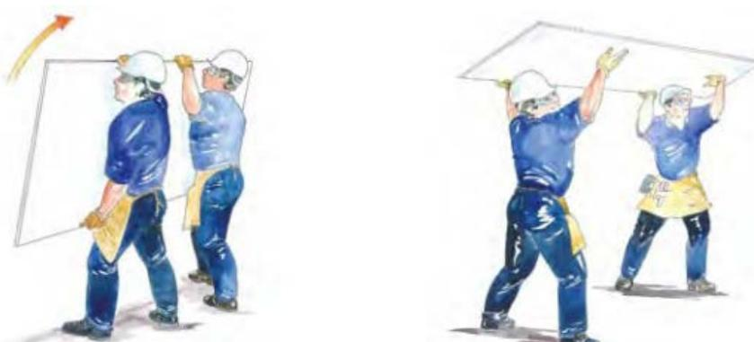
Fig. 2.7 Posizionare le lastre (compresi i controsoffitti) – Operazione da compiersi in 2 persone
