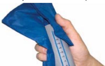
Fig. 3.68 Foto Pulizia dell'estremità piana del tubo PP HTplus
