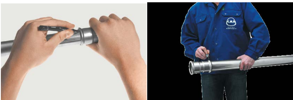
Fig 3.28 Foto Contrassegno della profondità di inserimento di un tubo all'interno di un raccordo.
