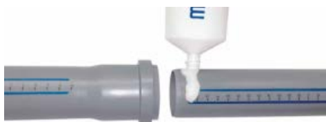
Fig. 3.69 Foto Lubrificazione dell'estremità piana del tubo PP HTplus
