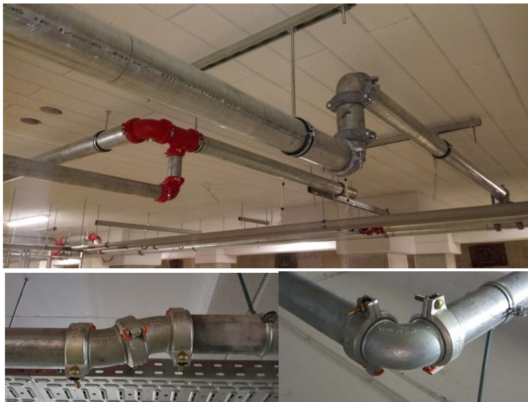
Fig. 3.33 Foto Frammenti di sistemi di approvvigionamento idrico realizzati con tubi zincati collegati con giunti scanalati e filettati.
