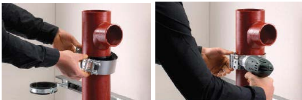
Fig. 3.79 Foto Posizionamento del morsetto in acciaio SV (SML prodotto da KZO).
