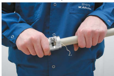
Fig. 3.12 Foto Rimozione del foglio di alluminio dal tubo in PP.
