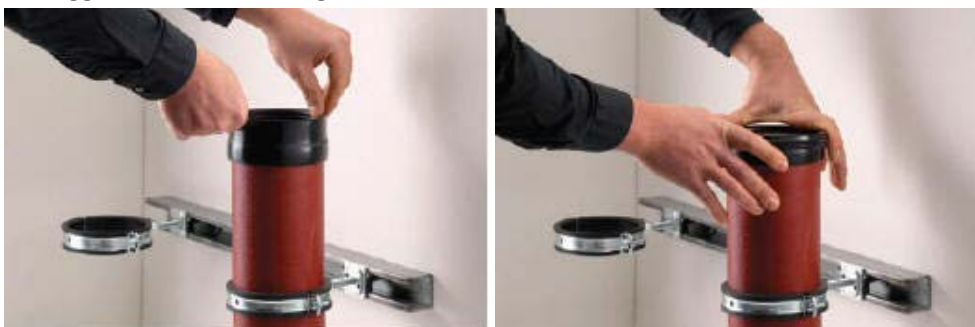
Fig. 3.77 Foto Posizionamento della boccola di gomma sul tubo SML prodotto da KZO (nota: le foto fig. 3.77 – 3.79 sono materiale promozionale della ditta KZO)
