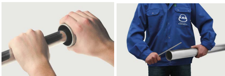
Fig. 3.25 Foto Smussatura dei bordi dei tubi di acciaio dopo il taglio
