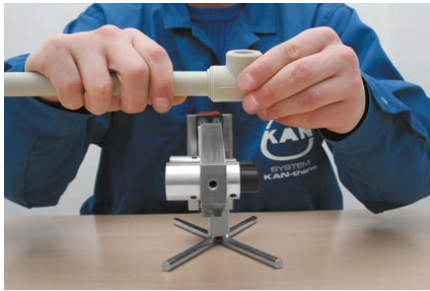
Fig. 3.15 Foto Immobilizzare il tubo con il gomito nel sistema in PP
