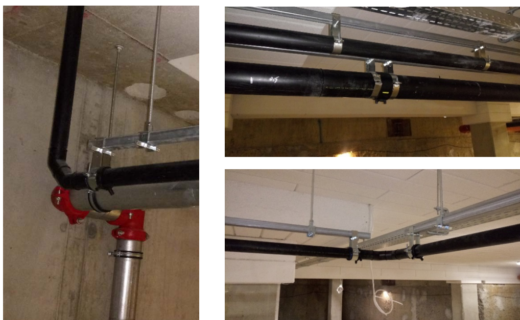
Fig. 3.96 Foto Installazione di tubi orizzontali Pluvia su brache di sistema. Raffigurate 2 soluzioni di punti fissi: mediante 2 prese installate sugli accoppiatori di elettrofusione, nonché una presa e una fascetta accessoria dedicati ai punti fissi nel punto di cambio della direzione verticale e orizzontale dell'installazione.
