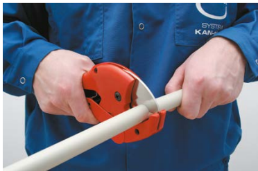
Fig. 3.10 Foto Taglio di un tubo in PP.
