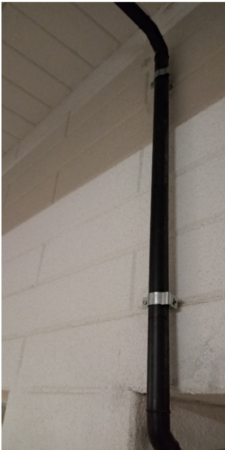
Fig. 3.95 Foto Montaggio dell'installazione Pluvia alla struttura dell'edificio su prese tubo tradizionali
