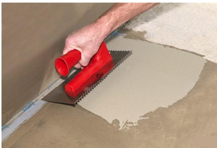
Fig. 7.20. Impermeabilizzazione del giunto tra pavimento e parete
