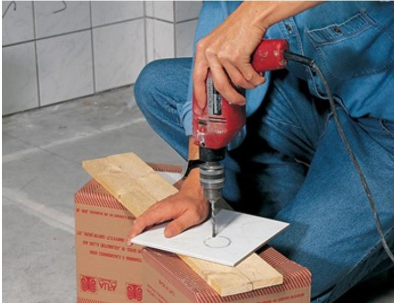
Fig. 7.30. Praticare un foro in una piastrella usando un trapano elettrico
