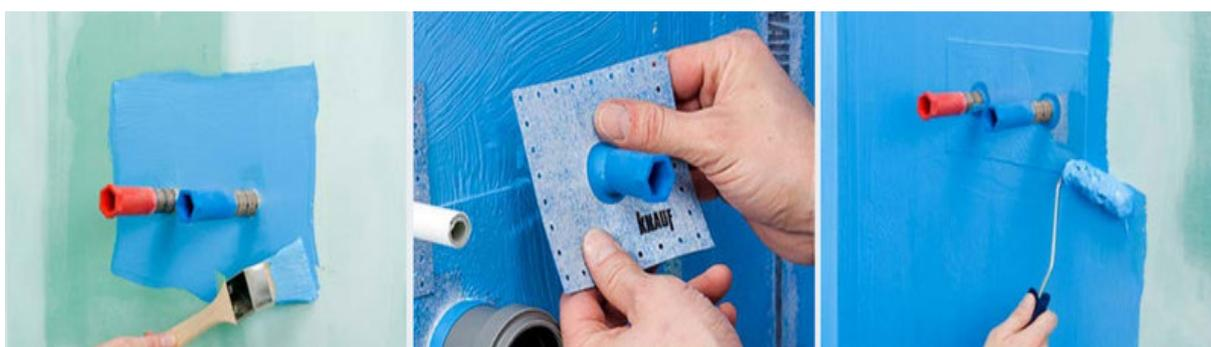
Fig. 7.6. Realizzazione di impermeabilizzazione attorno ai tubi
