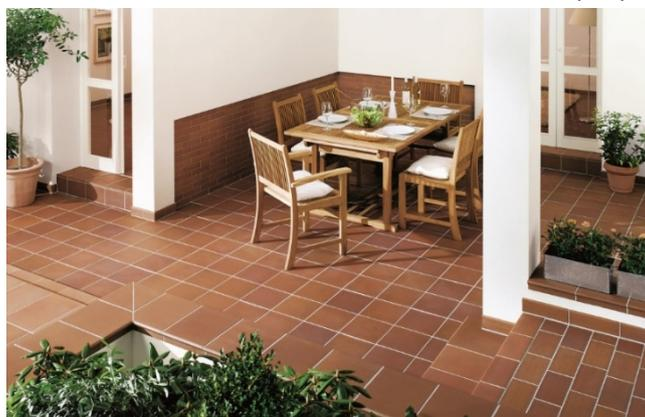
Fig. 3.11. Pavimento rivestito con piastrelle in klinker [<https://www.vokiskakeramika.lt/klinkerio-plyteles-naturkeramik.html>]
