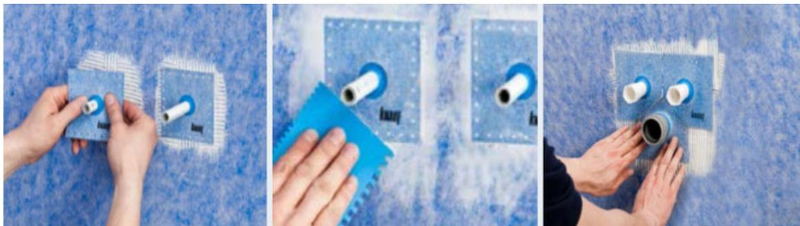
Fig. 7.10. Passaggi preliminari dell'isolamento dell'area di un tubo
