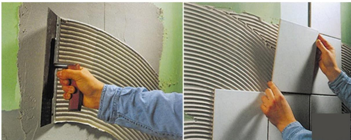
Fig. 7.22. Incollaggio di piastrelle di dimensioni normali
