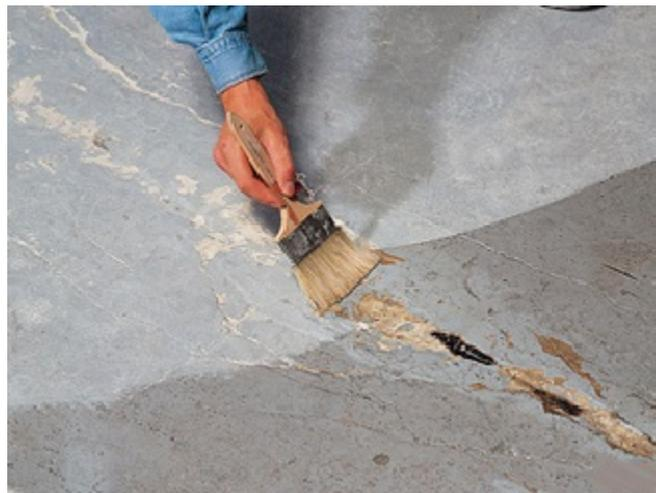
Fig. 7.19. Imprimatura della superficie
