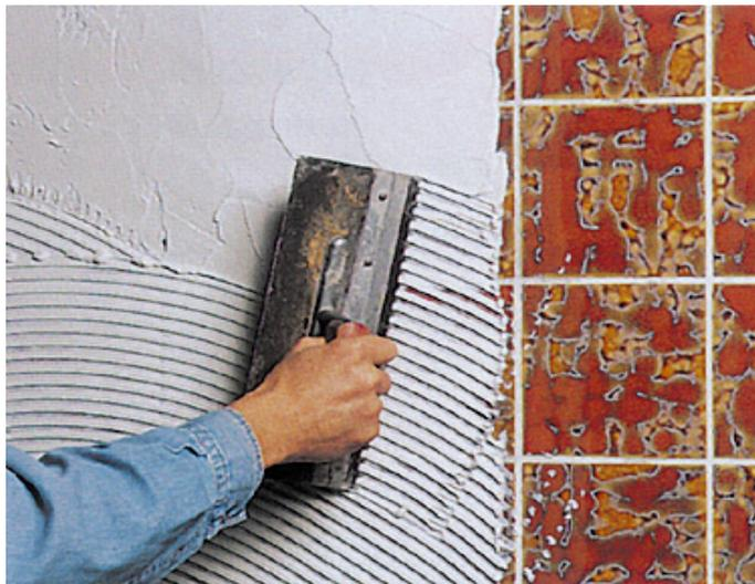
Fig. 7.26. Applicazione dell'adesivo
