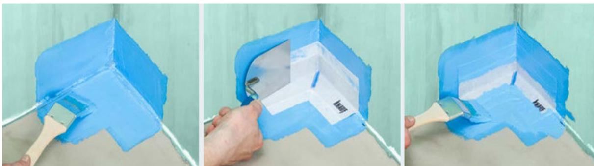
Fig. 7.5. Impermeabilizzazione corretta di un angolo
