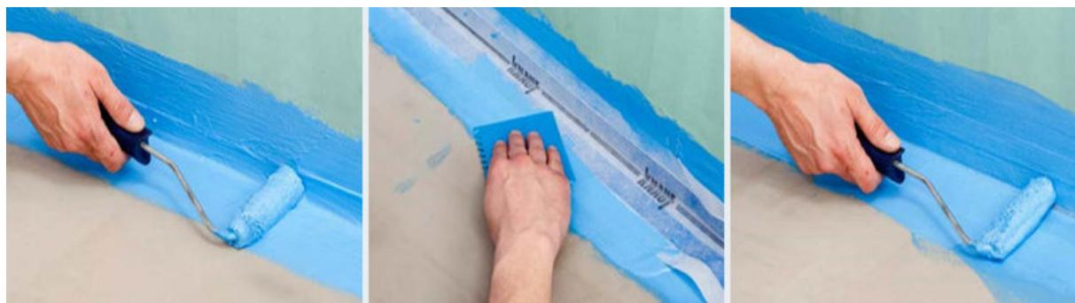
Fig. 7.4. Realizzazione di impermeabilizzazione di giunti per pareti e pavimenti
