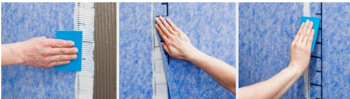
Fig. 7.9. Fasi dell'isolamento dei giunti con guaina impermeabilizzante
