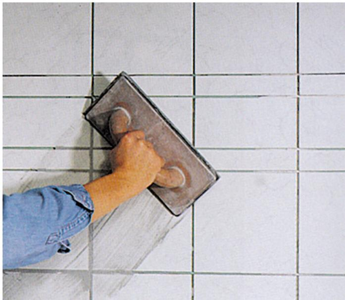
Fig. 7.33. Applicazione del riempitivo per giunti
