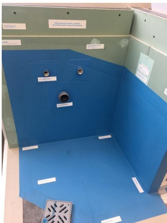
Fig. 7.2. Impermeabilizzazione [opera propria dell'autore]
