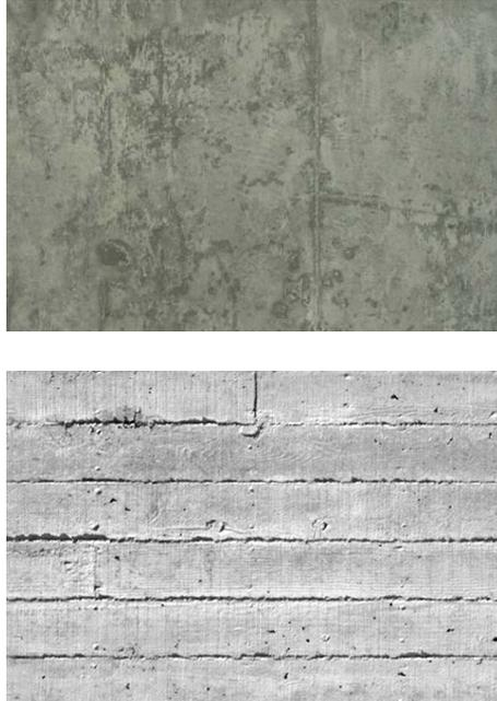
Fig. 3.22. Superfici di muri di cemento [da „PLYTELIJ KLOJIMO TECHNOLOGIJA“]
