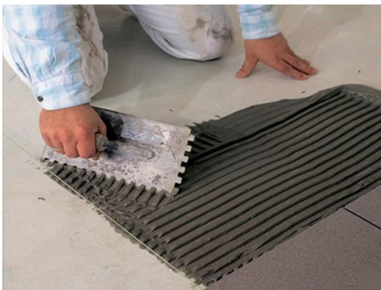
Fig. 7.23. Applicazione di un adesivo
