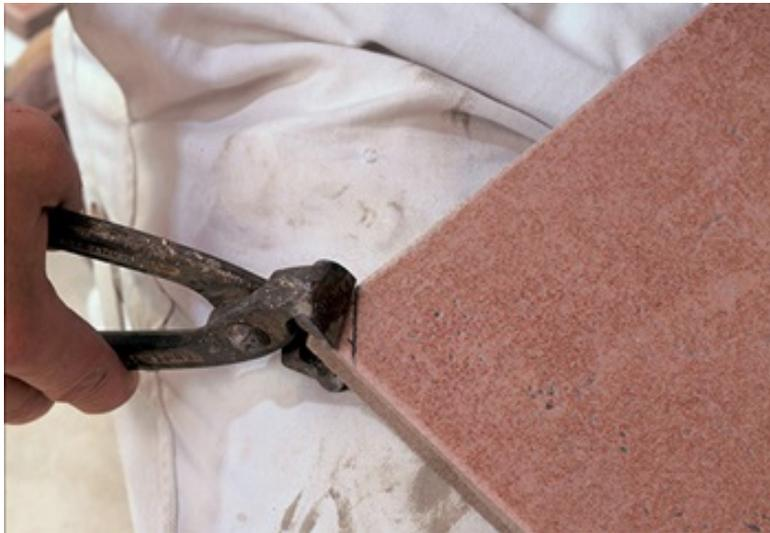
Fig. 7.28. Rottura della piastrella
