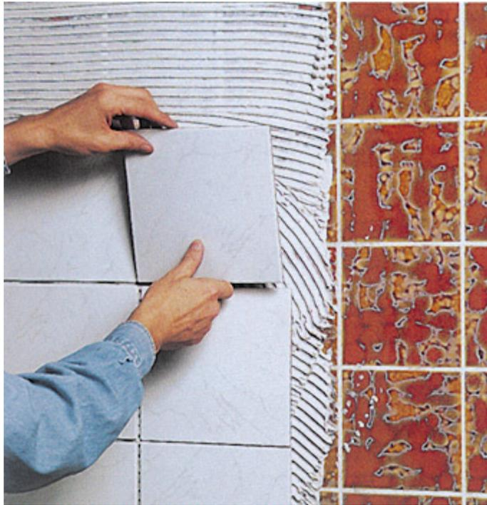
Fig. 7.27. Incollaggio delle piastrelle
