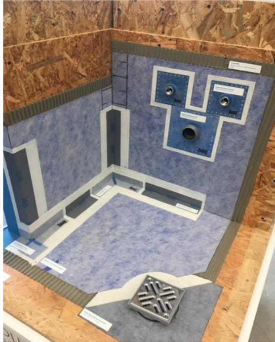
Fig. 4.7. Utilizzo della guaina impermeabilizzante [opera propria dell'autore]
