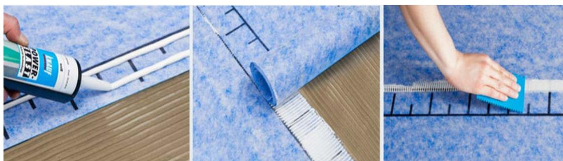
Fig. 7.12. Passaggi di giunzione di rivestimenti impermeabilizzanti
