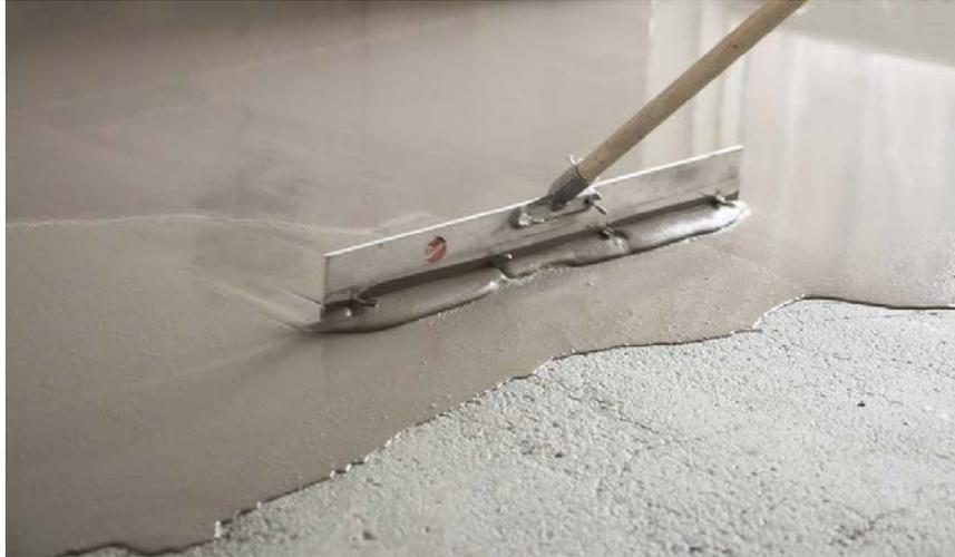
Fig. 4.1. Posa di una miscela autolivellante
