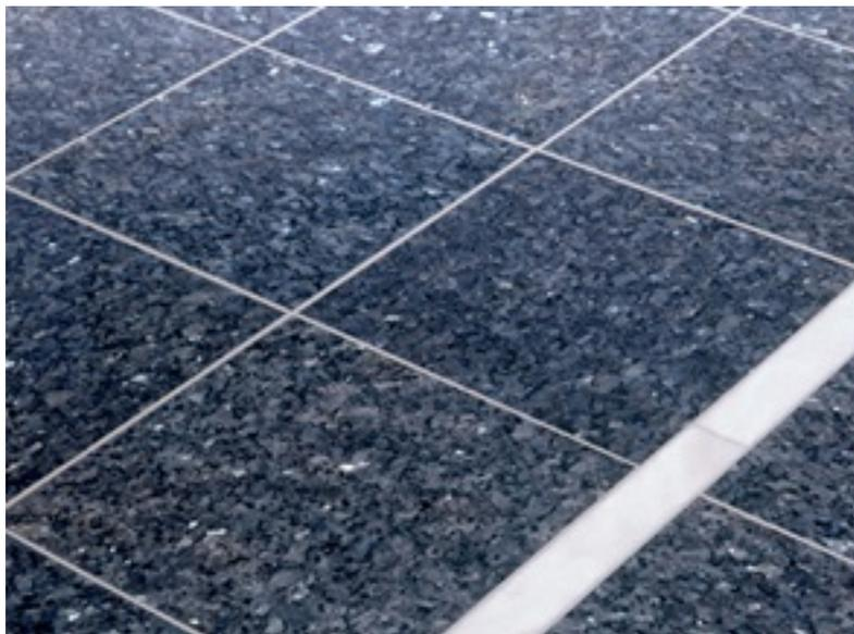
Fig. 7.31. Giunti per piastrelle e giunti di deformazione su pavimenti riscaldati
