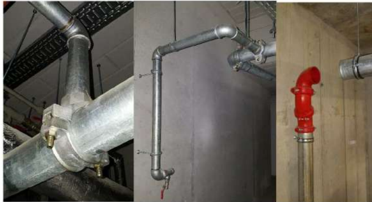
Nuotrauka 3.34. Vandentiekio sistemų fragmentai, pagaminti iš cinkuotų vamzdžių, sujungtų koplignėmis ir srieginėmis jungtimis, b dalis.
