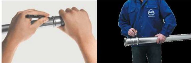
3.28 pav. Vamzdžio įstumiamo gylio į jungiamąją detalę žymėjimas.
