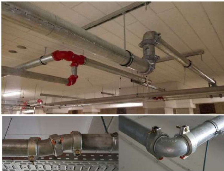
Nuotrauka 3.33. Vandentiekio sistemų fragmentai, pagaminti iš cinkuotų vamzdžių, sujungtų koplinginėmis jungtimis ir srieginėmis jungtimis, a dalis.
