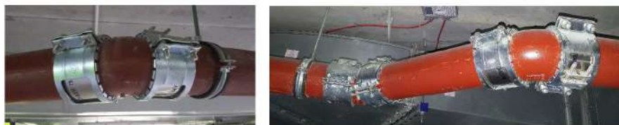
3.81 pav. Iš SML vamzdžių sumontuotos sistemos dalys, naudojant sustiprintas metalines apkabas.
