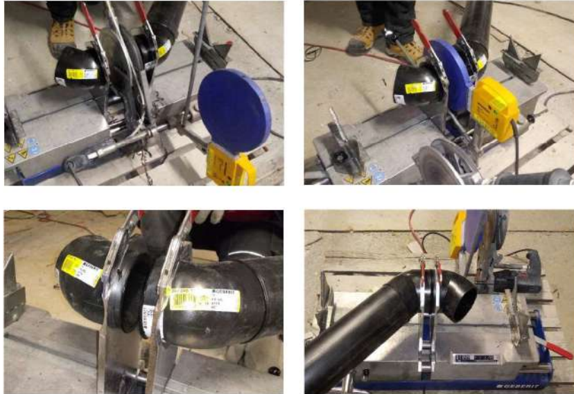
3.85 pav. (viršuje kairėje) kontaktinio paviršiaus apipjaustymas; (viršuje dešinėje) medžiagos šildymas; (apačioje kairėje) suvirintų elementų suspaudimas; (apačioje dešinėje) aušinimo fazė.
