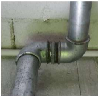
3.31 pav. Vandentiekio sistemos, pagamintos iš cinkuotų vamzdžių su srieginėmis jungtimis, fragmentas.
