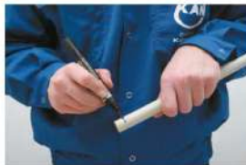
3.11 pav. Suvirinimo gylio žymėjimas PP vamzdyje.
