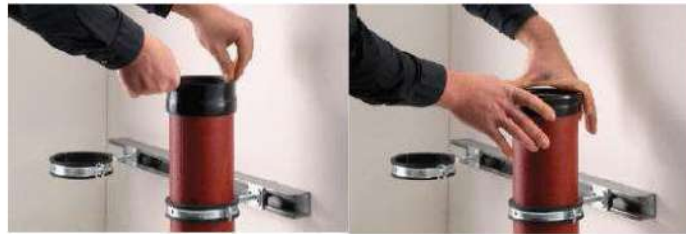
3.77 pav. Sandarinimo įdėklo uždėjimas ant KZO pagaminto SML vamzdžio
