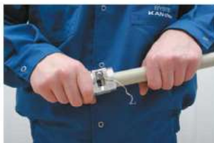
3.12 pav. Aliuminio folijos pašalinimas iš PP vamzdžių.
