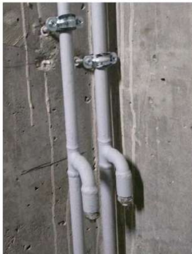
3.1 pav. Centrinio šildymo sistemos sumontuotos, suvirinant juodo plieno vamzdžius, fragmentas su antikorozyne danga ir atšakomis su srieginėmis jungtimis.
