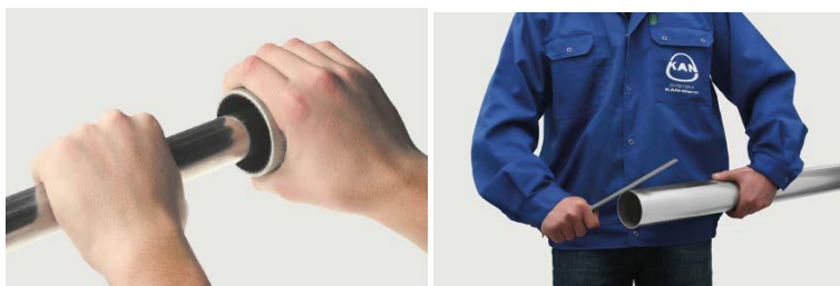
Rys. 3.25. Czynność fazowania krawędzi rur Steel po ich wcześniejszym przecięciu.
