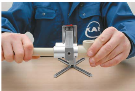
Rys. 3.13. Zgrzewanie rury z kolanem w systemie PP.
