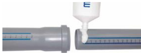
Rys. 3.69. Smarowanie bosego końca rury PP HTplus
