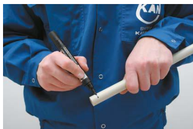
Rys. 3.11. Zaznaczanie głębokości zgrzewania na rurze PP.
