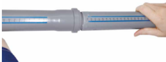
Rys. 3.70. Wprowadzenie bosego końca rury w kielich
