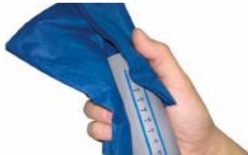
Rys. 3.68. Czyszczenie bosego końca rury PP HTplus
