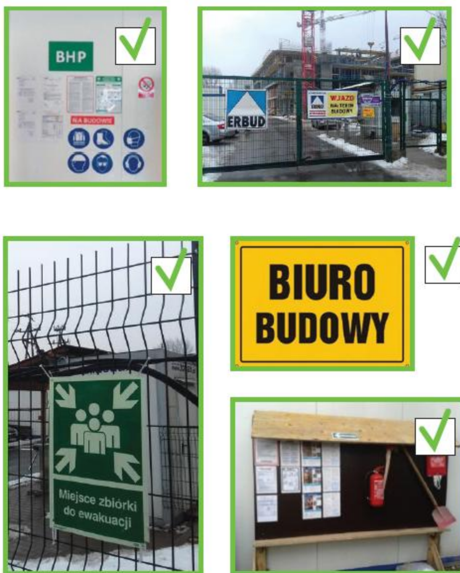
Rys. 2.2. Lokalizacja kluczowych miejsc bezpieczeństwa na placu budowy
