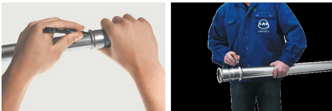
Rys. 3.28. Zaznaczanie głębokości wsunięcia rury w kształtkę.
