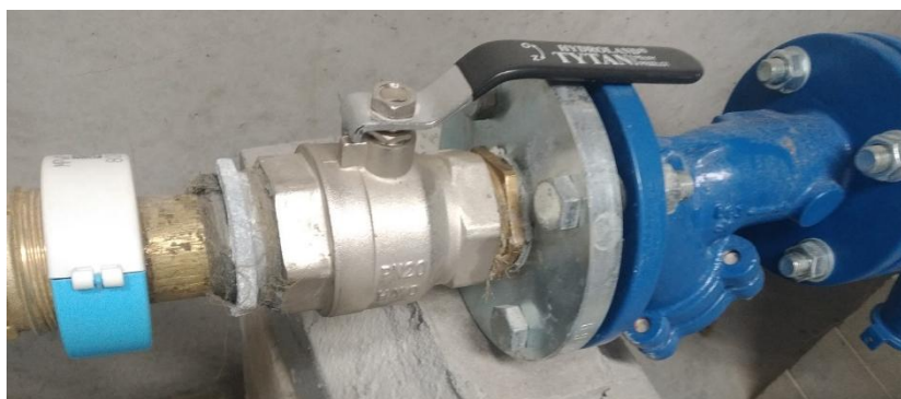
Rys. 3.32. Fragment instalacji wodociągowej połączonej z armaturą połączeniem gwintowanym (z lewej strony) i kołnierzowym
