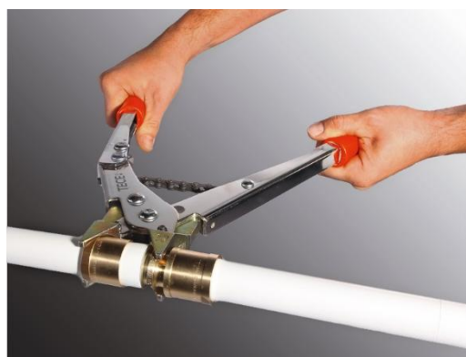
Rys. 3.42. Nasuwanie tulei stabilizującej połączenie
