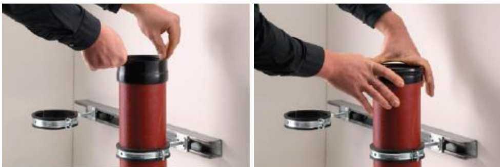
Rys. 3.77. Obsadzenie gumowego mankietu na rurze SML prod. KZO
