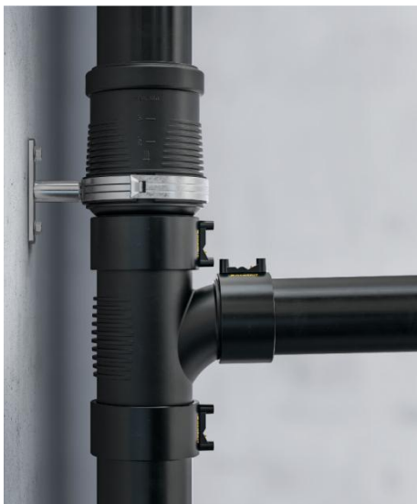
Rys. 3.87. Fragmenty gotowej, zauchwytywanej instalacji wykonanej w systemie PE firmy Geberit
