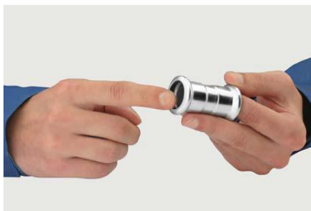
Rys. 3.26. Kontrola kształtki przed montażem.
