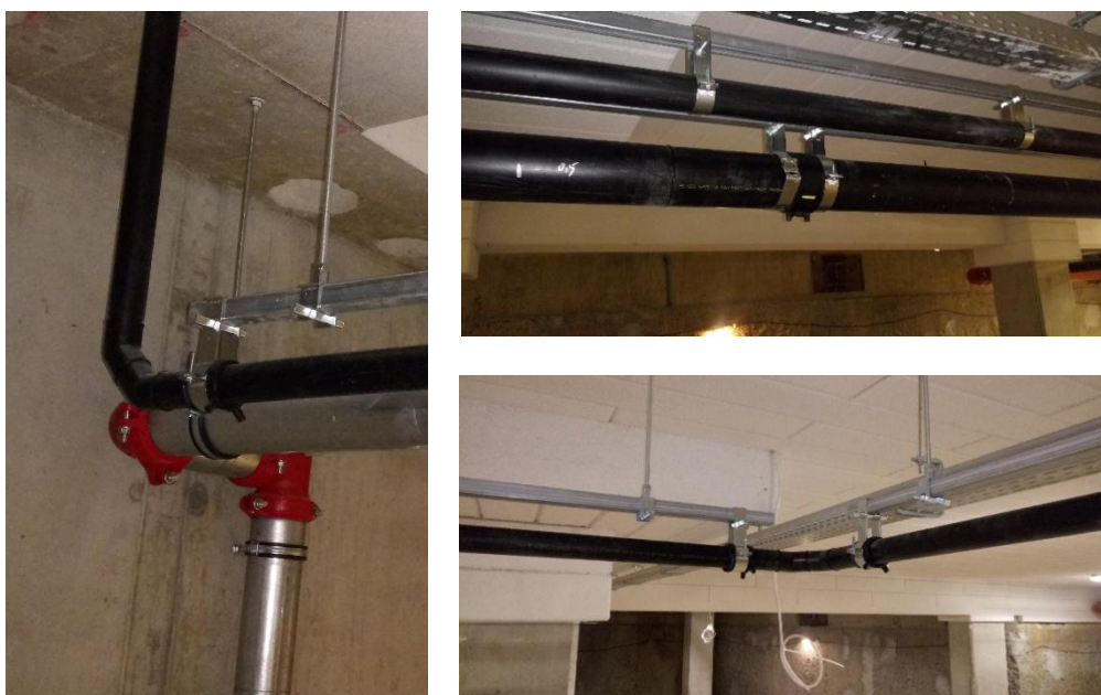
Rys. 3.96. Montaż poziomów Pluvii na zawiesiach systemowych. Widoczne 2 rozwiązania punktów stałych: za pomocą 2 uchwytów zamontowanych przy mufie elektrooporowej oraz uchwytu i akcesoryjnej opaski dedykowanej punktom stałym przy zmianie kierunku instalacji w poziomie i pionie.
