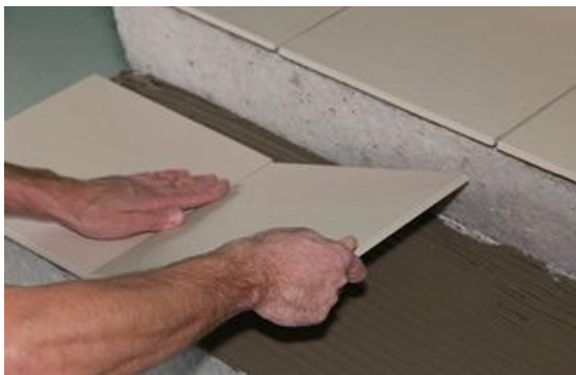
Rys. 7.36. Montaż płytek na schodach
