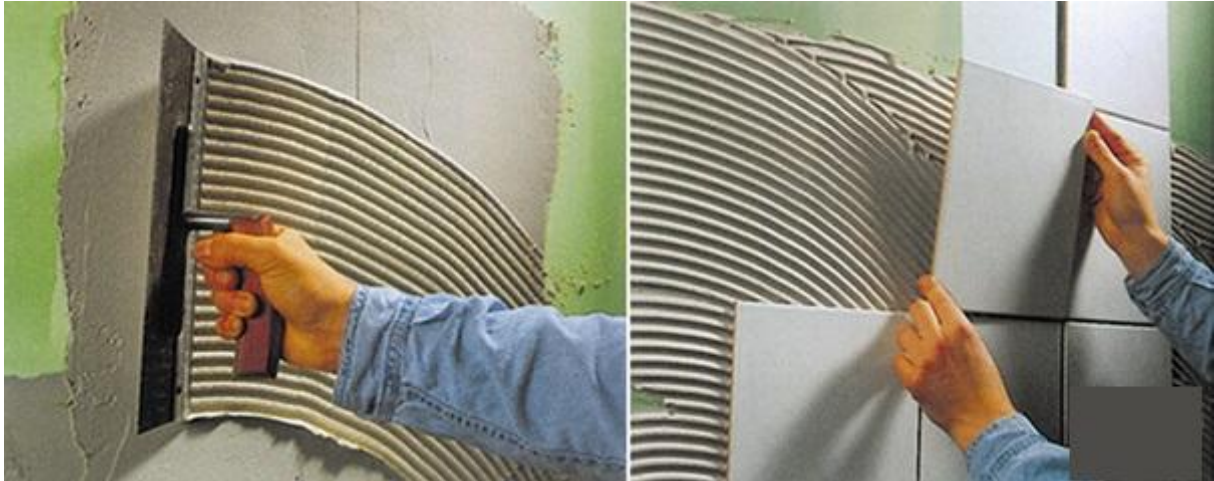
Rys. 7.22. Przyklejanie płytek standardowych rozmiarów
