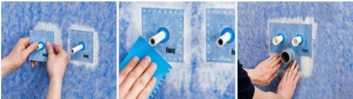
Rys. 7.10. Etapy wstępnego izolowania rur
