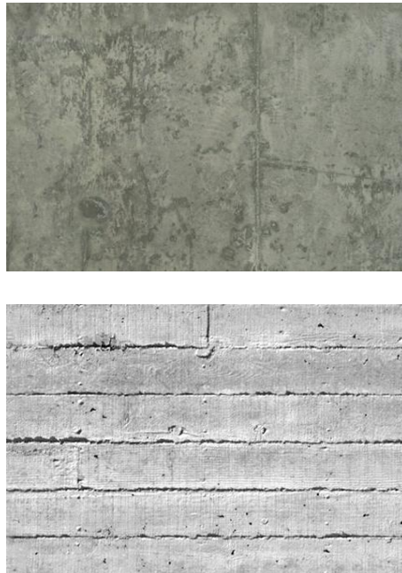
Rys. 3.22. Powierzchnie ścian betonowych [z „PLYTELIŹ KŁOJIMO TECHNOLOGIJA“]
