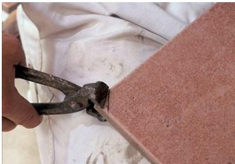
Rys. 7.28. Łamanie płytki
