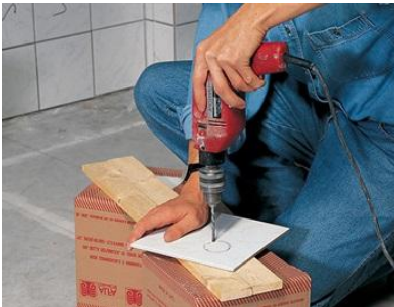
Rys. 7.30. Wiercenie otworu w płytce
