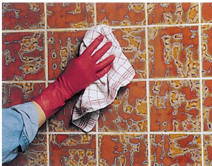
Rys. 7.25. Odtłuszczanie płytek
