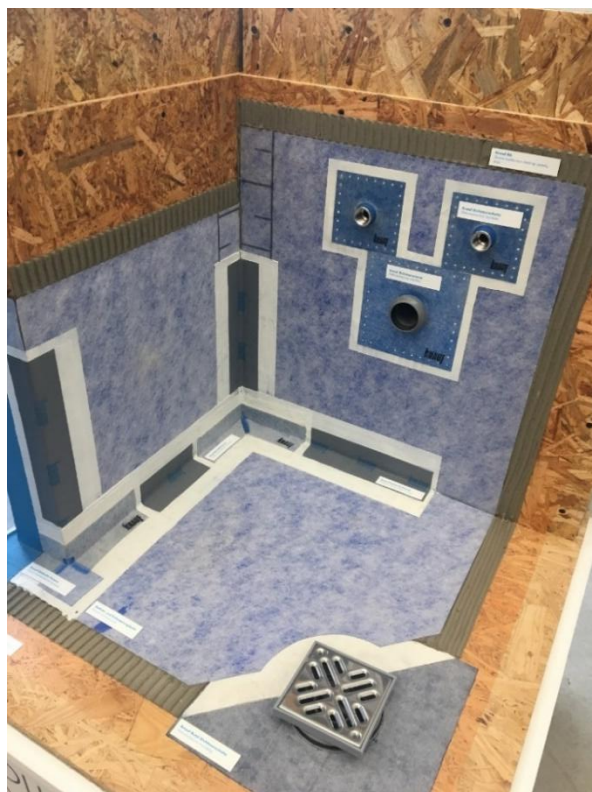
Rys. 4.7. Użycie hydroizolacji w rolce [zdjęcie autora]
