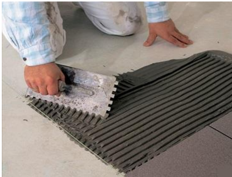
Rys. 7.23. Nakładanie kleju
