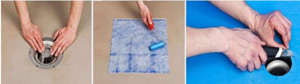
Rys. 7.7. Wykonywanie izolacji wokół otworu w podłodze
