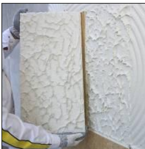
Rys. 7.16. Płytką pokryta zaprawą klejową [archiwum autora]
