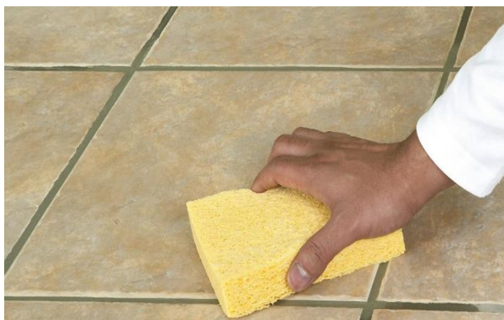
Rys. 4.26. Podstawowe czyszczenie płytek [ https://enamai.lt/lt/statybos-akademija/kaip-priziureti-plyteles ]
