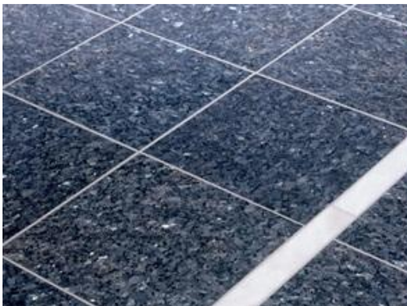
Rys. 7.31. Połączenia i połączenie odkształcalne na ogrzewanych podłogach
