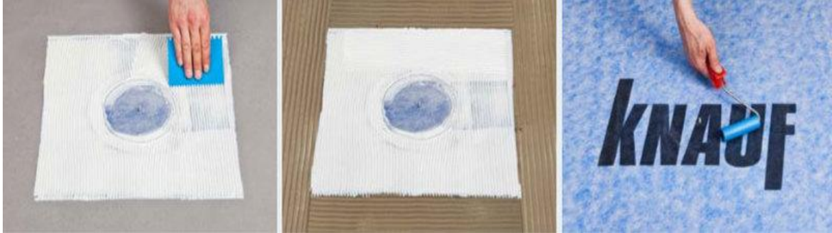
Rys. 7.11. Dalsze etapy izolowania rur
