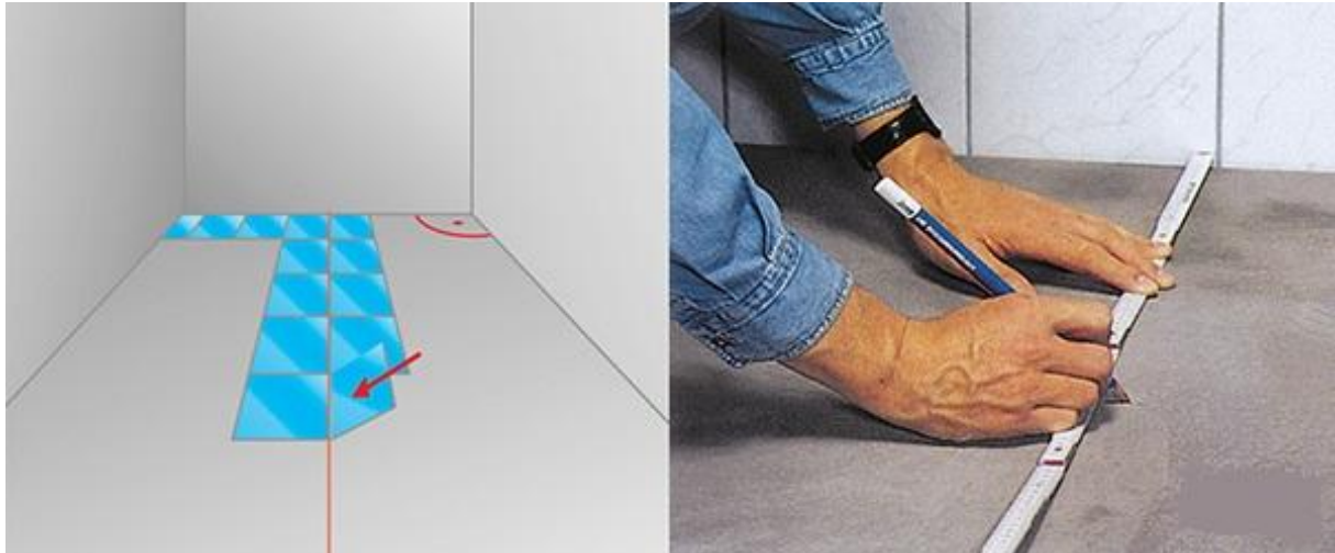
Rys. 7.21. Planowanie układu płytek
