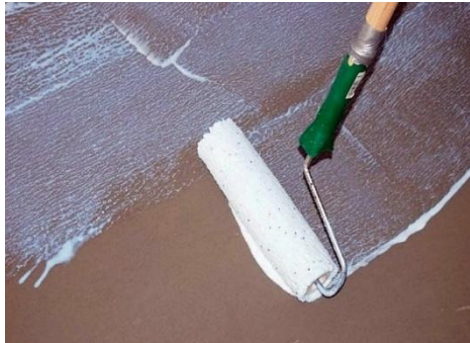
Rys. 7.3. Gruntowanie
