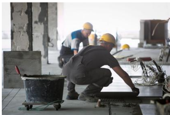
Rys. 2.3. Glazurnicy przy pracy [ http://www.statybajums.lt/temos/darbo-gaisrine-sauga ]
