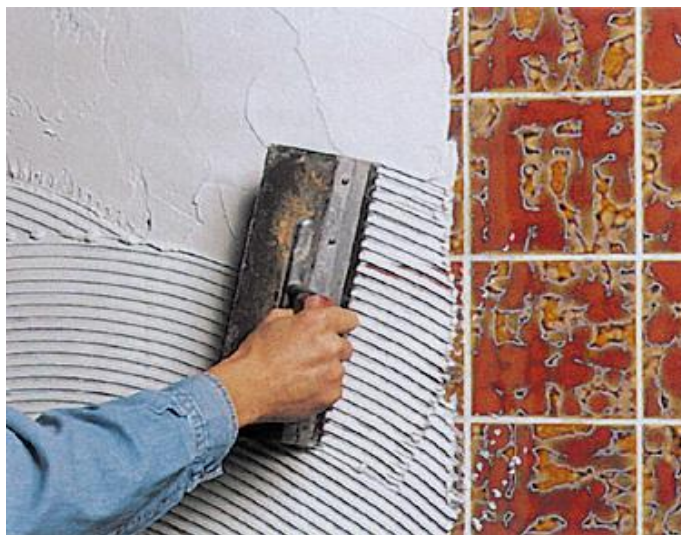
Rys. 7.26. Nakładanie zaprawy klejowej
