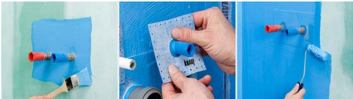
Rys. 7.6. Wykonywanie hydroizolacji wokół rur
