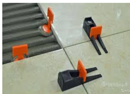
Rys. 5.19. System poziomowania (licowania) płytek
