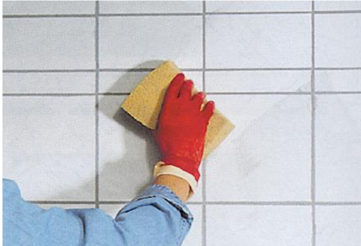
Rys. 7.34. Zwilżanie spoin
