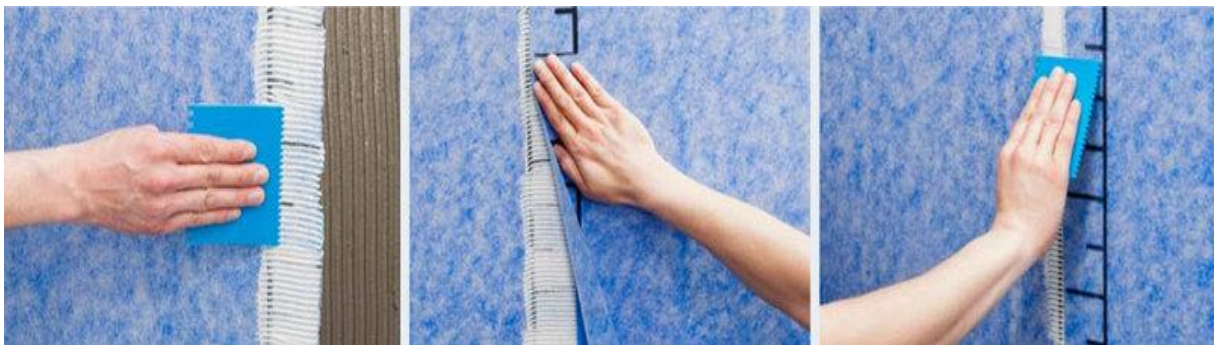
Rys. 7.9. Etapy izolowania połączeń izolacji w rolce
