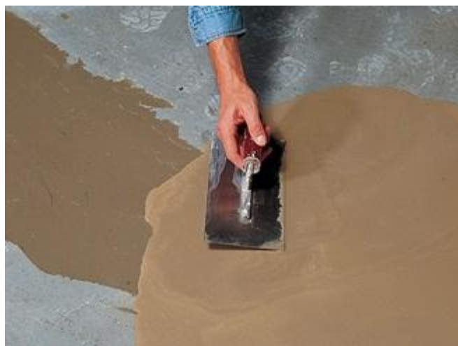
Rys. 7.18. Pierwszy etap przygotowania podłoża
