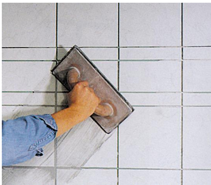
Rys. 7.33. Nakładanie zaprawy do spoinowania
