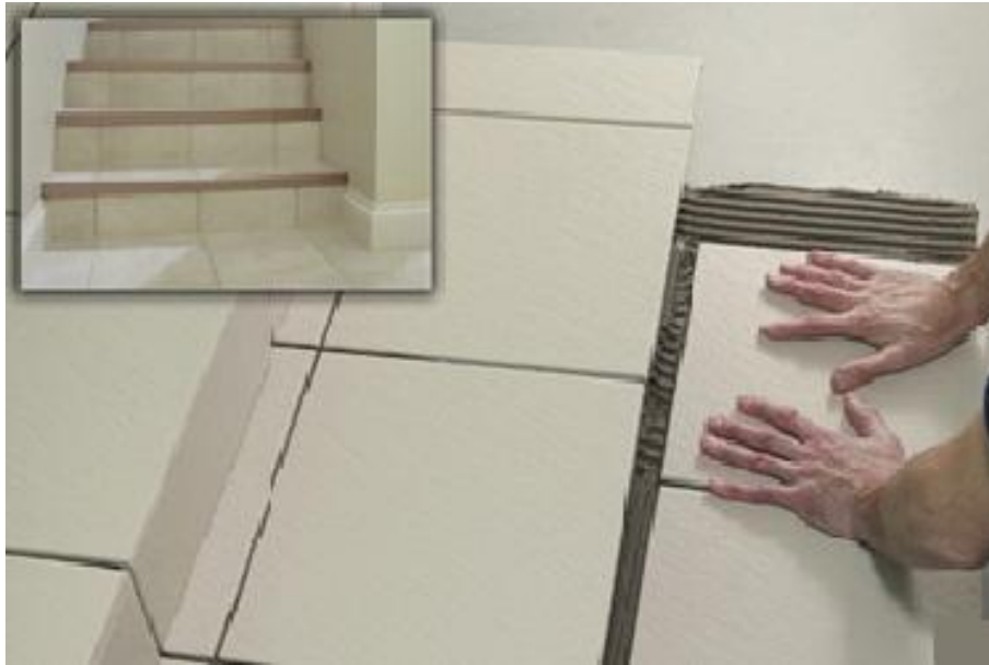
Rys. 7.37. Montaż kolejnych płytek
