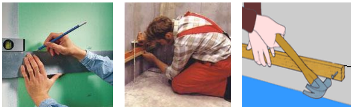
Rys. 7.43. Oznaczanie drugiego rzędu i mocowanie listwy startowej [z „PLYTELIŹ KŁOJIMO TECHNOLOGIJA“]
