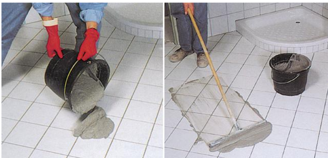
Rys. 7.35. Impregnowanie spoin
