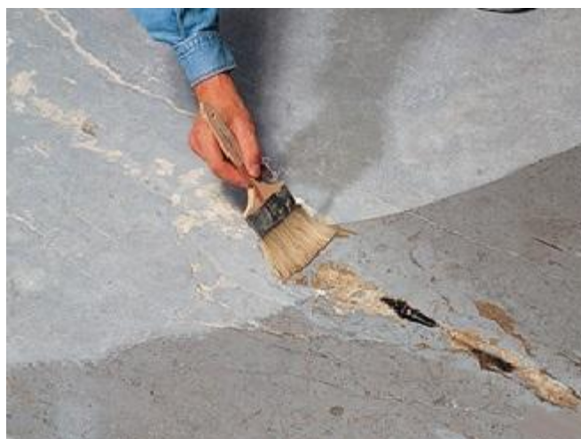
Rys. 7.19. Gruntowanie podłoża
