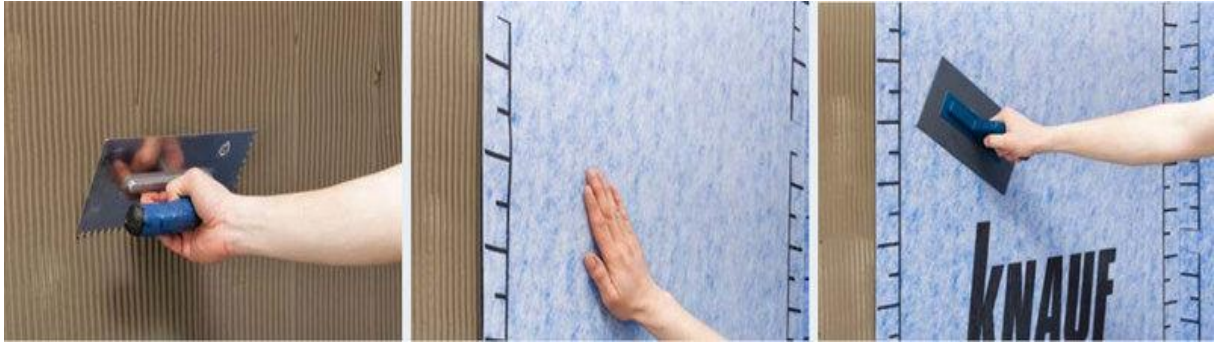
Rys. 7.8. Etapy nakładania izolacji w rolce
