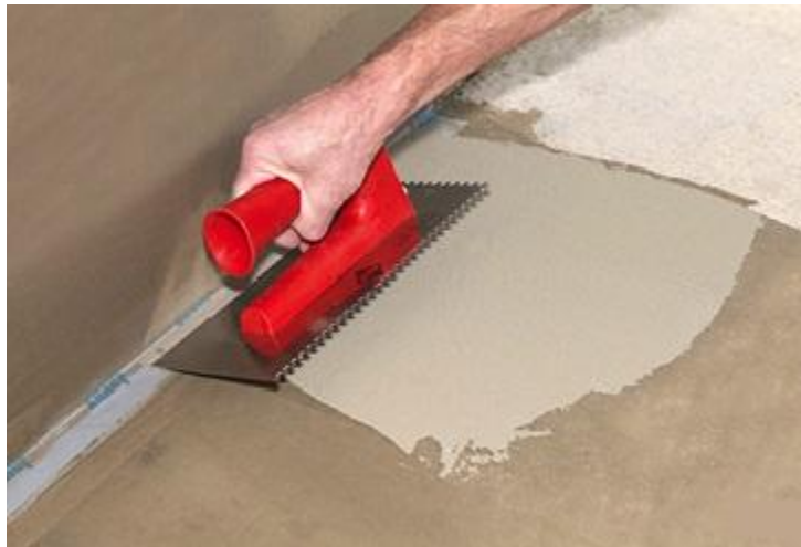
Rys. 7. 20. Wykonywanie hydroizolacji styku podłogi i ściany
