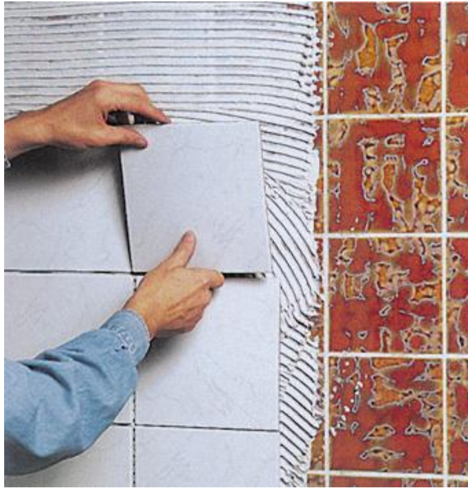
Rys. 7.27. Przyklejanie płytek
