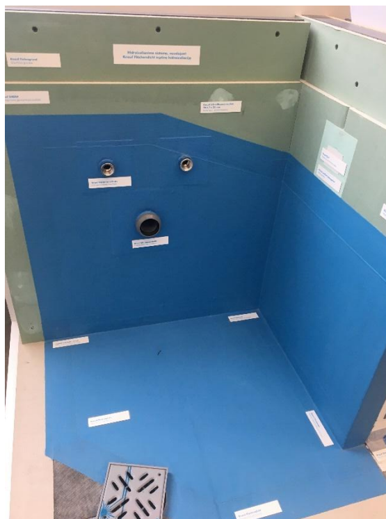
Rys. 7.2. Położona hydroizolacja [zdjęcie autora]
