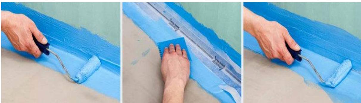
Rys. 7.4. Wykonywanie hydroizolacji na styku ścian i podłogi
