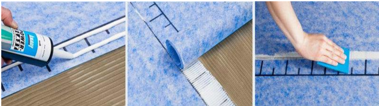
Rys. 7.12. Etapy łączenia powłok hydroizolacji
