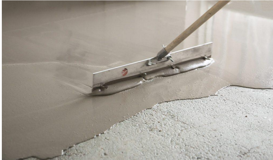
Rys. 4.1. Nakładanie wylewki samopoziomującej
