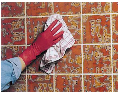
1. Senas plyteles nuriebalinti valikliu ir gruntuoti sukibimą užtikrinančiu gruntu
