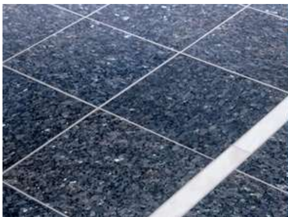
Plytelių siūlės ir deformacinė siūlė ant šildomų grindų.
